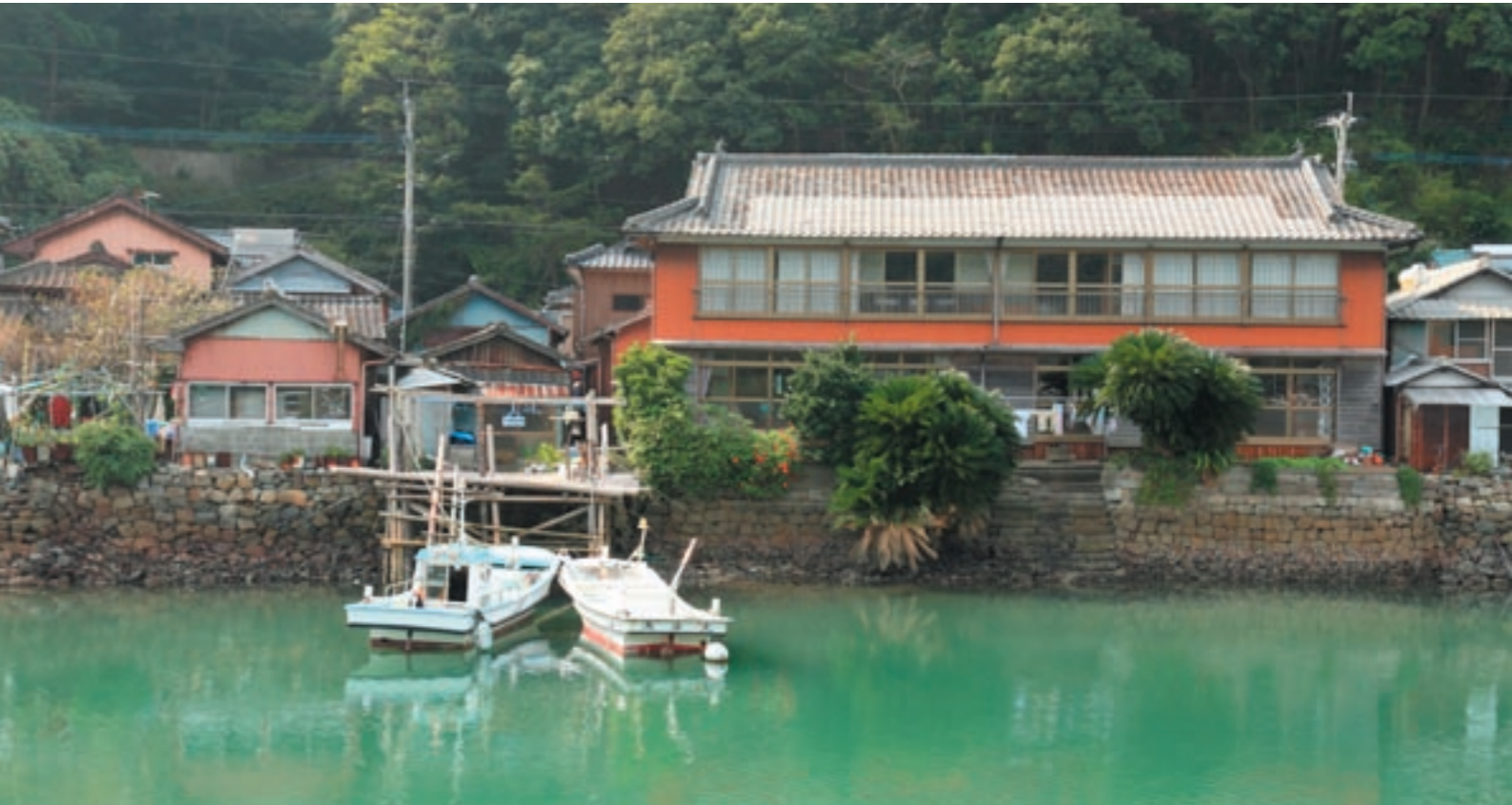
幹線道路から集落に続く、入り江沿いには石組みの堤が続き、古い家並みと会いまって懐かしい漁村の風景が残されている。
